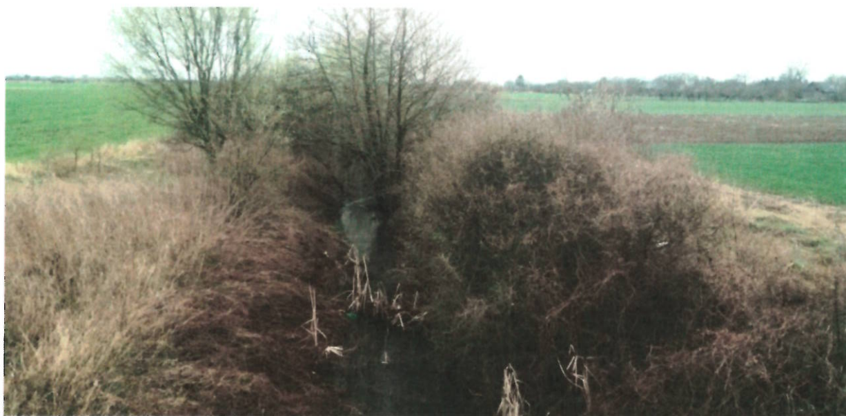
Obr.č.9: Sobranecký kanál v k.ú.Ostrov
